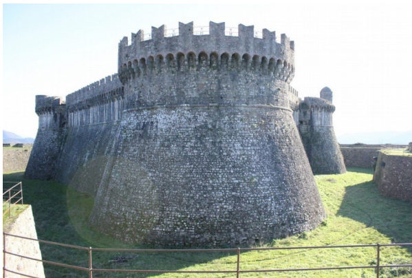
Foto 6: Fortaleza de Sarzanello. El torreón y la escarpa pronunciada son elementos típicos de período de "transición"; mientras, son todavía elementos del pasado, las ladroneras en voladizo de la parte superior.(foto: L.Casini y P.Cid)
