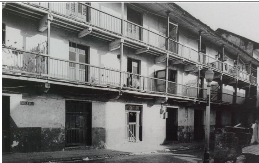
Figura N°5. Fachada principal del edificio de las Cátedras de Teología y Moral de la Real y Pontificia Universidad de San Javier en la Calle 8ª Oeste, con modificaciones posteriores (vanos de puerta ventanas, balcones corridos y cubierta de techo en zinc) realizadas, posiblemente, durante el siglo XX para los nuevos usos. Fachada del Hotel Washington, del Club Internacional y por último, edificio de inquilinato durante el siglo XX. Fotografía: E. Tejeira, 1986
