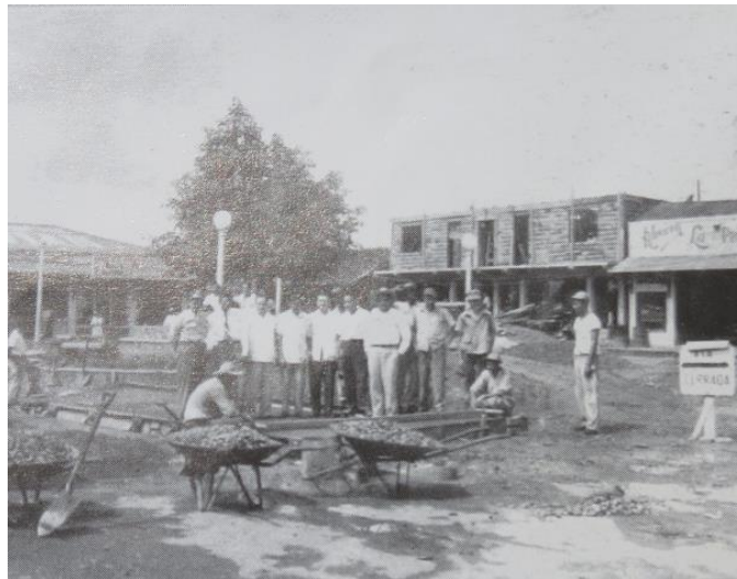
Ilustración 23. Pavimentación de la Placita San Juan de Dios 1970. Nótese algunos edificios en construcción alrededor de La Placita.
