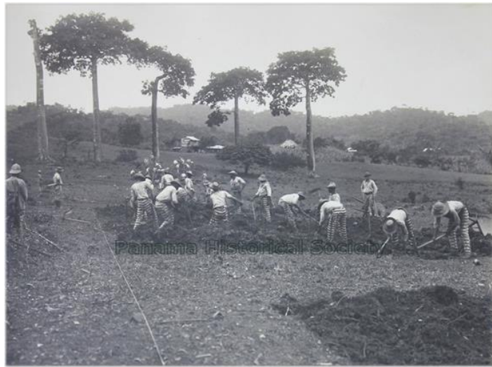
Ilustración 19. ejemplo de construcción de caminos a inicio de Siglo XX. Convictos construyendo un camino entre Pedro Miguel y Miraflores - Zona del Canal agosto 1910. foto de Panama Historical Society.
