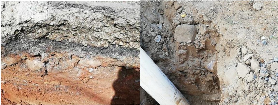
Ilustración 7. Rastro del empedrado debajo de calle Segunda de Santiago de Veragua, trabajos de Alcantarillado de la ciudad. Foto Arq. Sebastián Aguilar M.
