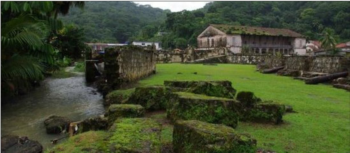
Figura 3. Colapso de la estructura muraria en el Fuerte de San Jerónimo por la Quebrada Guinea. Fuente: TripAdvisor España
