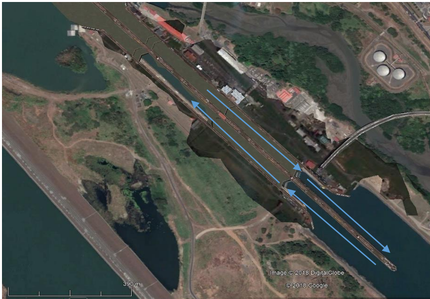
Figura 8: Esclusa de Miraflores. Dos cámaras.
